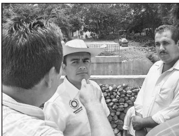
La obra de lo que será el puente "Centenario" que unirá a las colonias San Antonio Tomatlán y El Terrero, conoció sus alcances de construcción el secretario de gobierno, Fidel Calderón, quien recibió amplias explicaciones de las características de la obra y de su avance actual.
