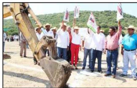
Autoridades de la SAGARPA, SEDRU y del ayuntamiento de Huetamo, dieron el banderazo del inicio de la construcción de un Centro de Acopio para el almacenamiento de granos con capacidad para cinco mil toneladas, en beneficio de agricultores de Michoacán y Guerrero.
