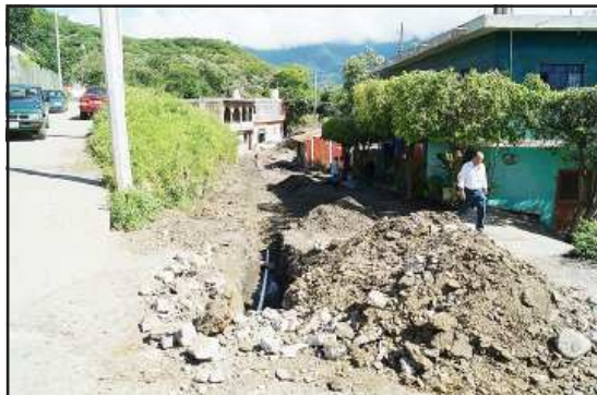
El alcalde Jorge Conejo Cárdenas, supervisó la pavimentación con concreto hidráulico de la calle Israel Tentory de la cabecera municipal, teniendo una inversión de un millón 200 mil pesos.
