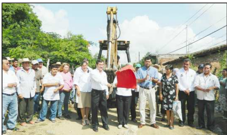
Inició la construcción de la pavimentación de la calle 16 de Septiembre en la Tenencia de Angao, de San Lucas, por parte del edil Miguel Rentería Galarza.
