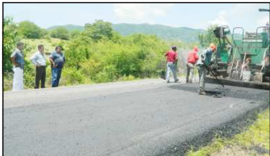
Trabajos de reencarpetación asfáltica han sido realizados en el tramo carretero entre Chumbítaro y Tacupa, que se encontraba totalmente deteriorado, lo que dificultaba el tránsito de vehículos en esta importante rúa que comunica con el Estado de Guerrero.
