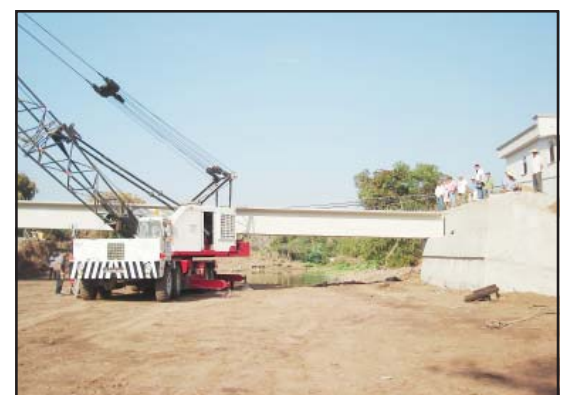
Así es como luce la prime trabe al ser colocada en su lugar que servirá de soporte al igual otras más para resistir las losas por donde habrán de pasar los vehículos, y así desahogar el tráfico vehicular de la avenida Madero que cada día aumenta su congestión durante las primeras horas del día y hasta bien entrada la tarde.
