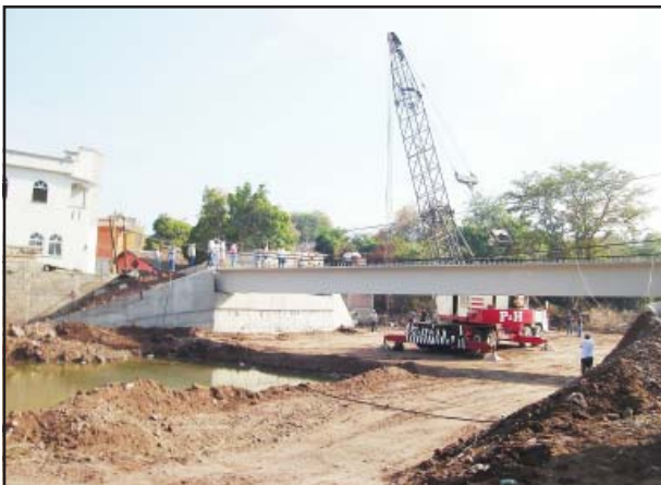
Enorme y majestuoso se vio la trabe al momento de ser colocada por potente "pluma" que la levantó y la colocó en el soporte de concreto.
