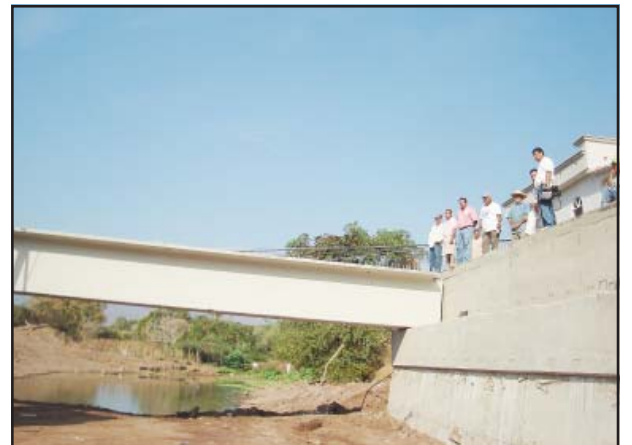
Enorme y majestuoso se vio la trabe al momento de ser colocada por potente "pluma" que la levantó y la colocó en el soporte de concreto.
