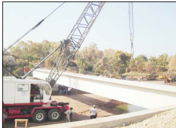
Enorme y majestuoso se vio la trabe al momento de ser colocada por potente "pluma" que la levantó y la colocó en el soporte de concreto.
