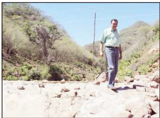
En El Zapote de Coendeo, el presidente municipal, Román Nava Ortiz, inspeccionó el avance de construcción de una presa que habrá de beneficiar a buen número de habitantes de ese lugar en los múltiples usos del vital líquido.
