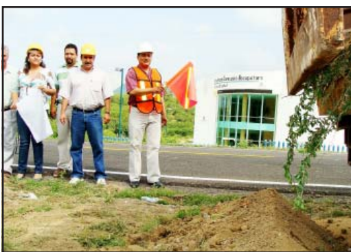
El presidente municipal de Nocupétaro, Francisco Villa García, acompañado por funcionarios municipales, puso en marcha los trabajos de un andador peatonal que unirá a Nocupétaro con el Hospital Regional Comunitario.
