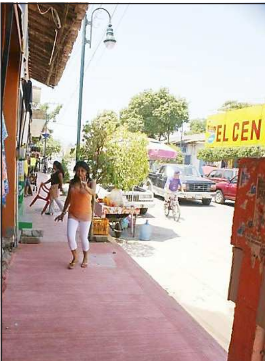
Así quedó la banqueta sin la rampa, después de las modificaciones que se le hicieron para evitar accidentes.
