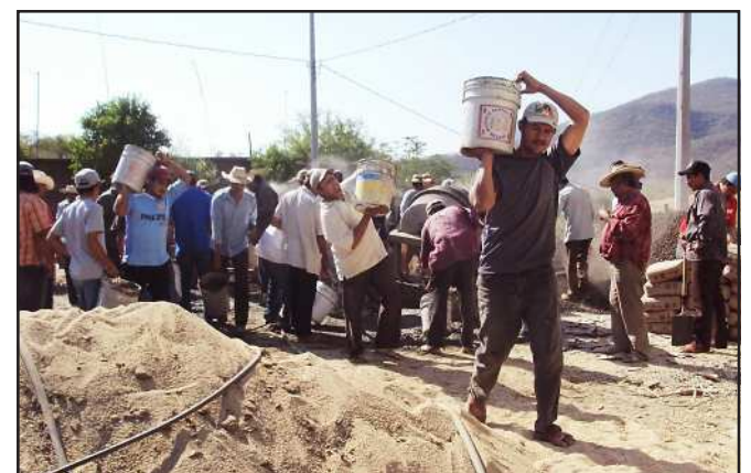
Formando cuadrillas de trabajadores voluntarios, los habitantes de la comunidad El Cuitzillo, realizaron labores para el “colado” de la capilla de ese centro de población, habiendo participado con su trabajo el presidente municipal de Carácuaro, Román Nava Ortiz.
